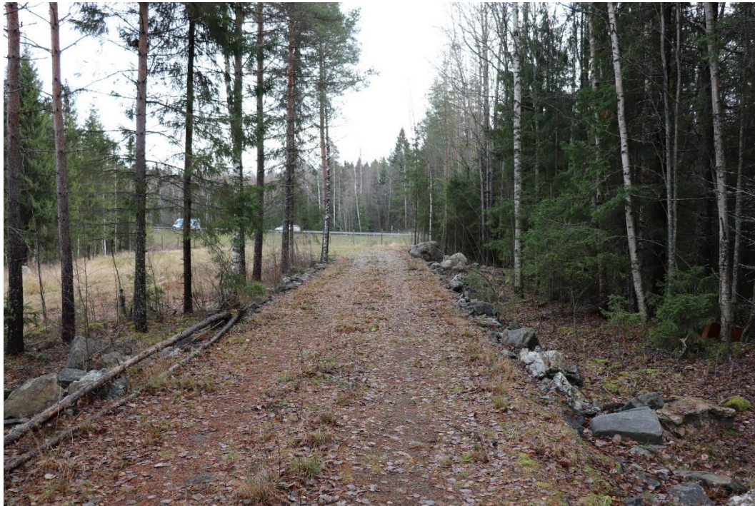
Kuva 4. Lintukalliontien vanhempaa linjausta Valtatie 9:n pohjoispuolella marraskuussa 2018. Maastossa näkyvä tielinja on perustettu murskeella, joka on todennäköisesti peräisin viimevuosikymmenten aikana tehdyistä tienparannuksista.
