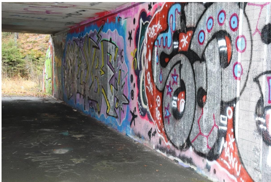
Kuva 1. Onkijärven levähdyspaikan läheisyydessä oleva alikulkutunneli.
